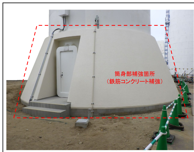
図1 第二付属排気筒の耐震補強
